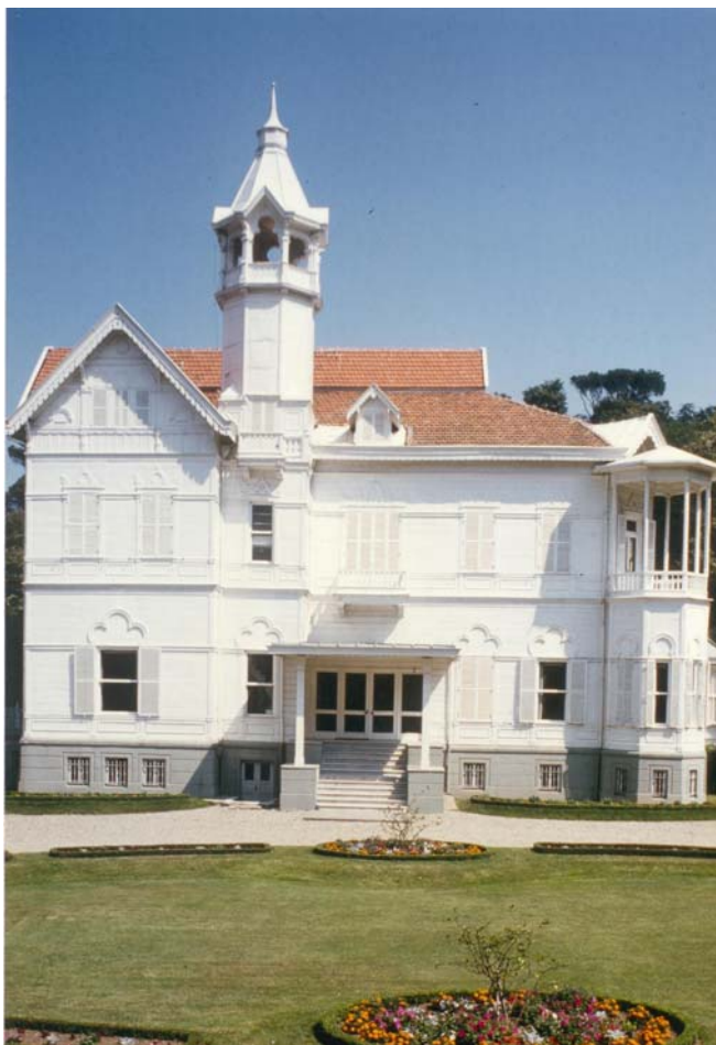
Ansicht des Botschaftergebäudes von Norden
