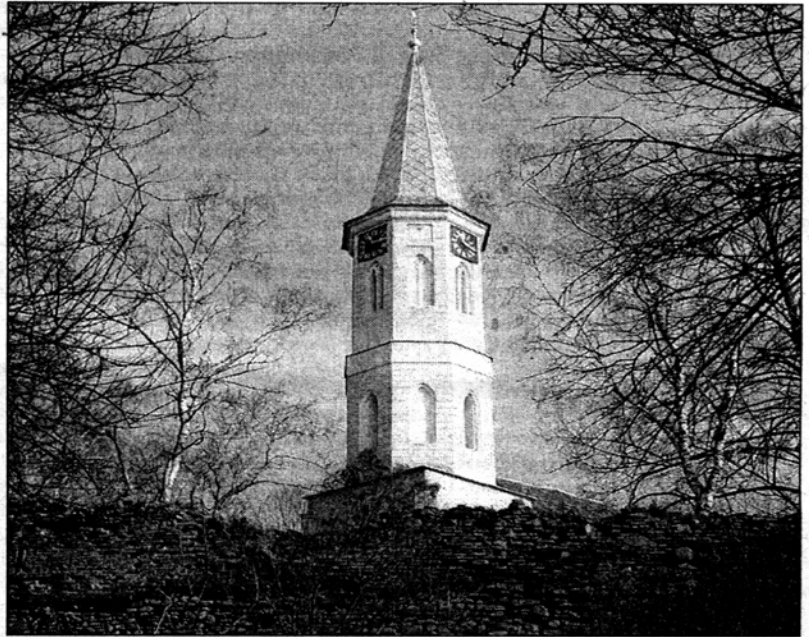
Paradebeispiel für den entdeckten Trend: Die Kirchenburg Alzen/Aljâna: Fast tadelloser Turm und einsturzgefährdete Ringmauer
